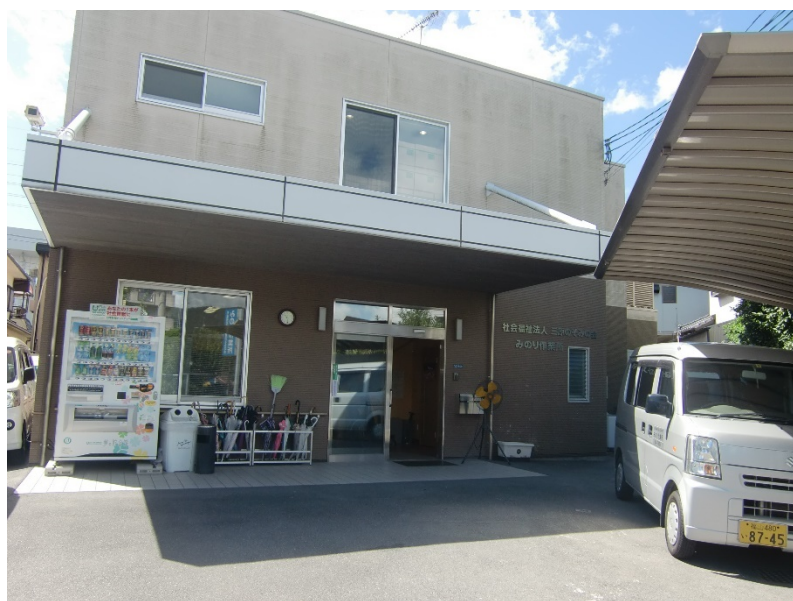
▲みのり作業所
